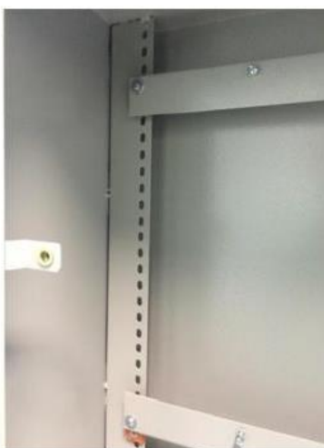
Figura 2: Detalhe da longarina e aplicação dos isoladores
