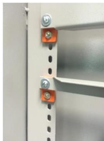
Figura 2: Detalhe da longarina e aplicação dos isoladores
